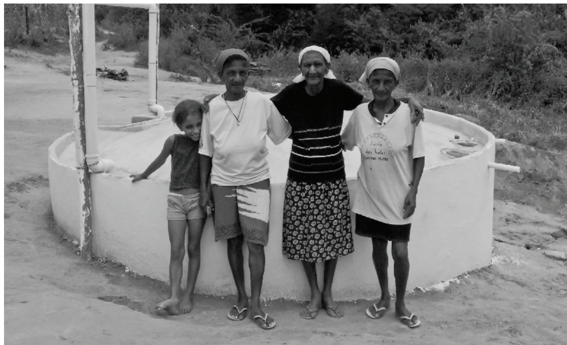
Figura 3: Cisterna de captação de água das chuvas construída pelos moradores da comunidade Mutuca de Cima (município Coronel Murta) e pela equipe do GESTA
